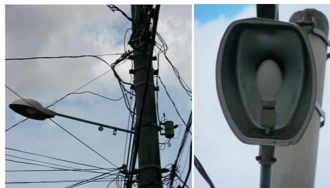
Figura 3 - Luminária aberta, com braço curto e lâmpada Vapor Mercúrio.
